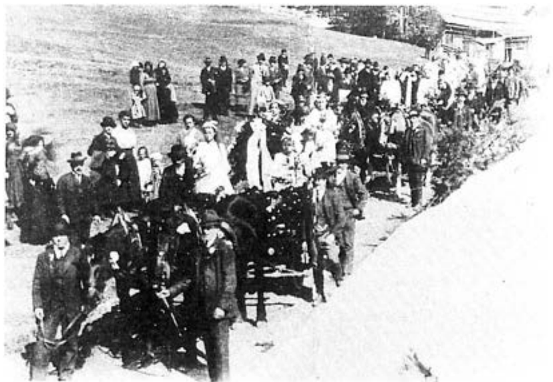
Der Glockenzug beim Rudolfschacht
