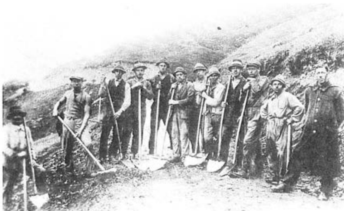
Bleiberger beim Bau der Glocknerstraße
