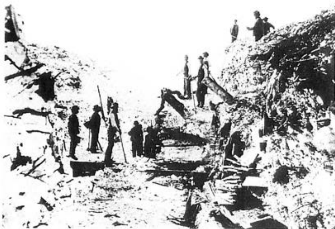
Rettungsarbeiten 1879 in Hüttendorf
