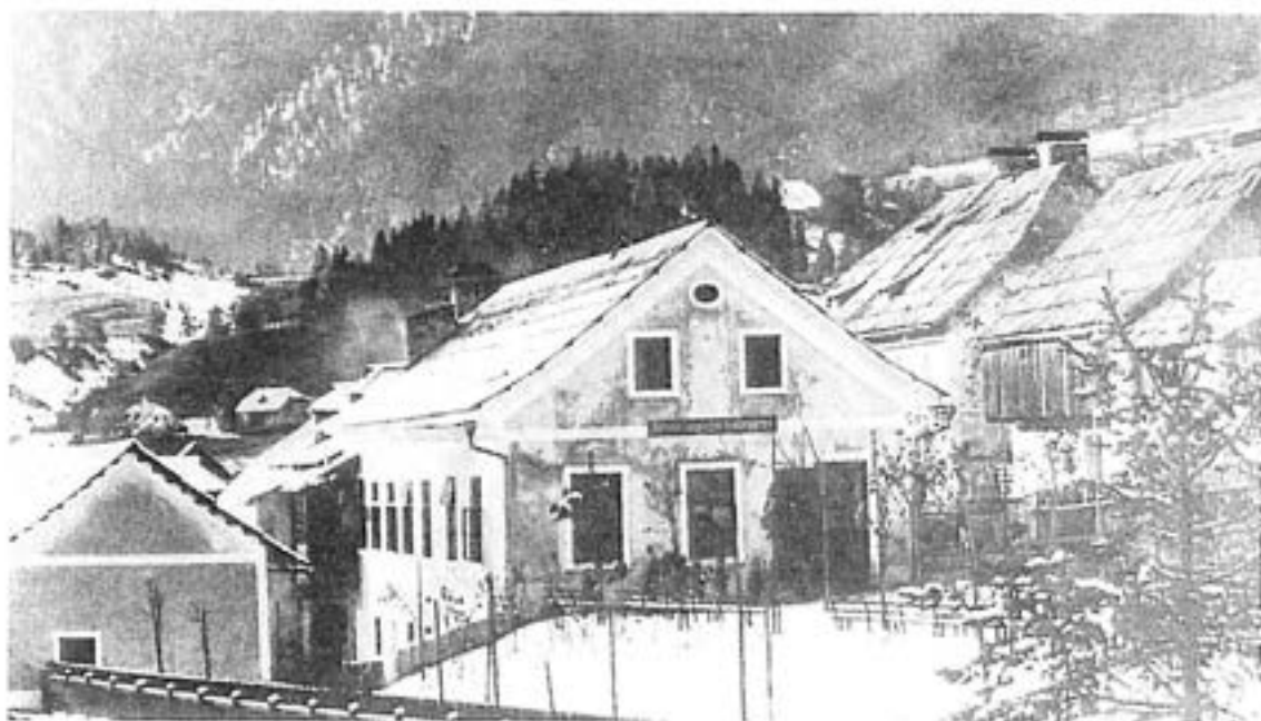
Das Haus des Lang'schen Kindergartens (heute abgerissen)
