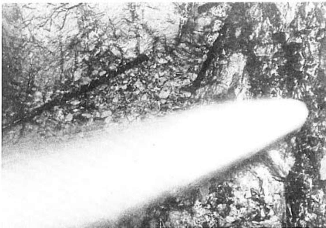
Der Wassereinbruch der Therme
