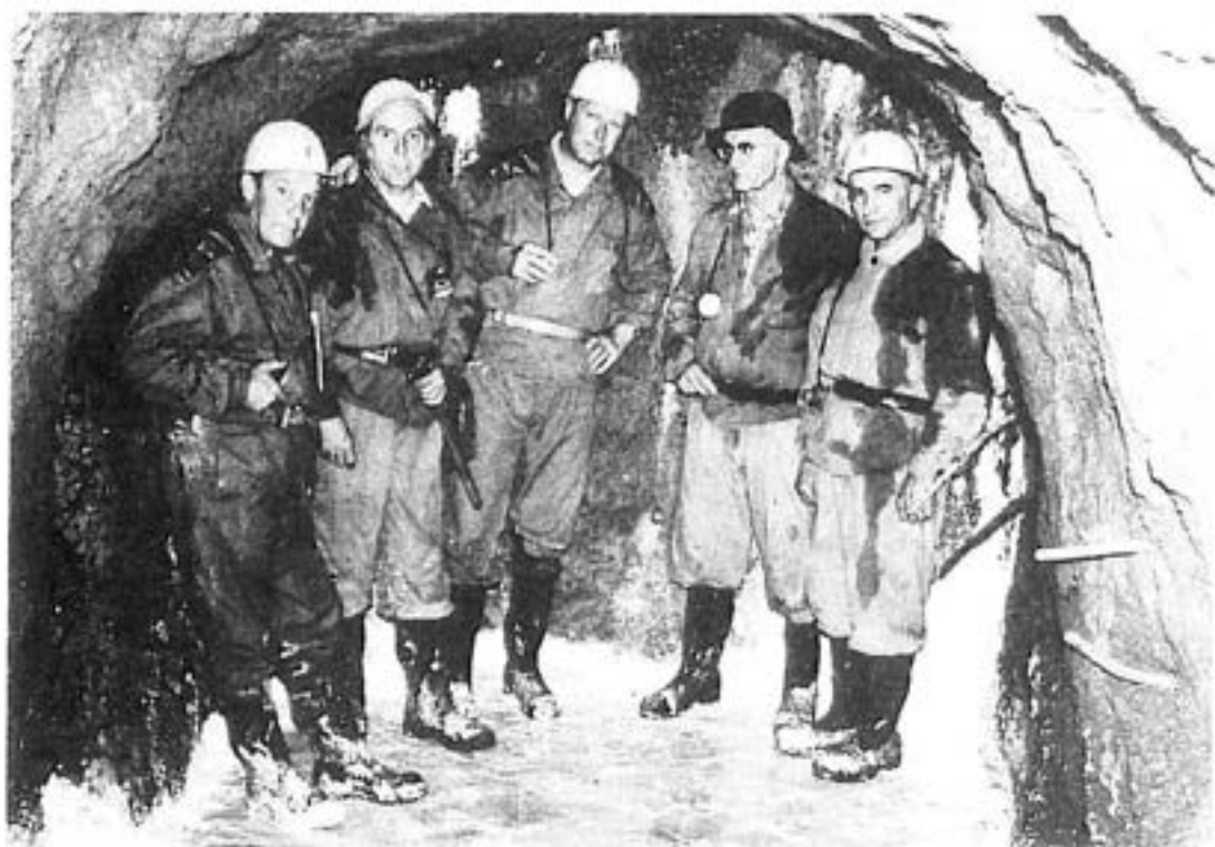
Schlußbefahrung anläßlich der Kollaudierung am Thermendamm - v. l. n. r.: Oberhulmann Karl Mlekusch, Berginspektor Hermann Rainer, Bergdirektor Wolfram Enzfelder, Berghauptmann Rolf Amtmann, Bürgermeister Friedrich Stock.
